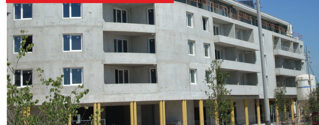
Immeuble en construction BBC «Les Terrasses Grand'Place» Bourg les Valence
