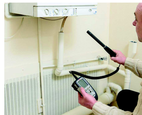
Contrôle chaudière au gaz
