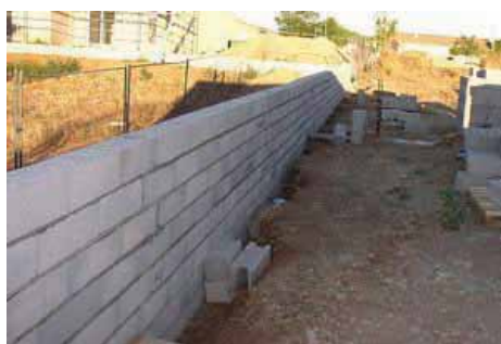
Construction d'un mur mitoyen
