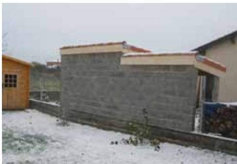
Garage construit sur mur mitoyen
