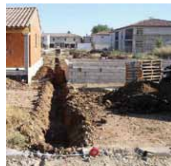
Fondations sur limite pour mur de clôture
