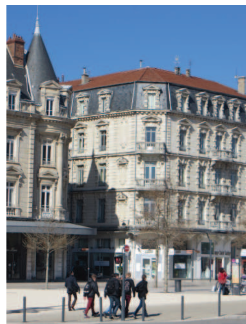
Immeubles anciens - Valence
