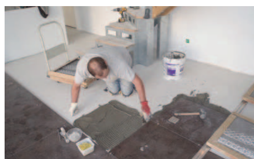
Travaux : pose de carrelage
