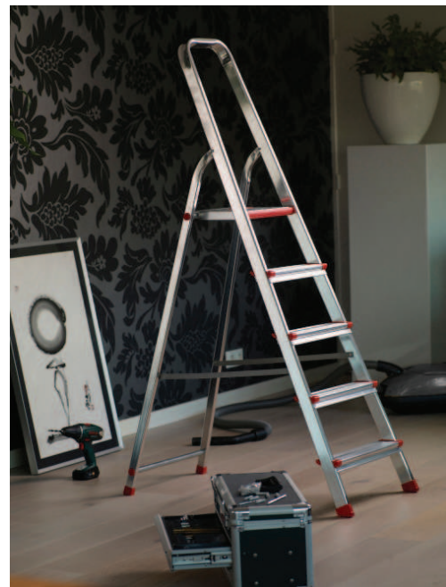
Travaux : aménagement intérieur
