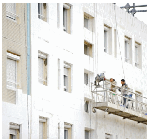
Source : InfoEnergie - Travaux d'isolation par l'extérieur
