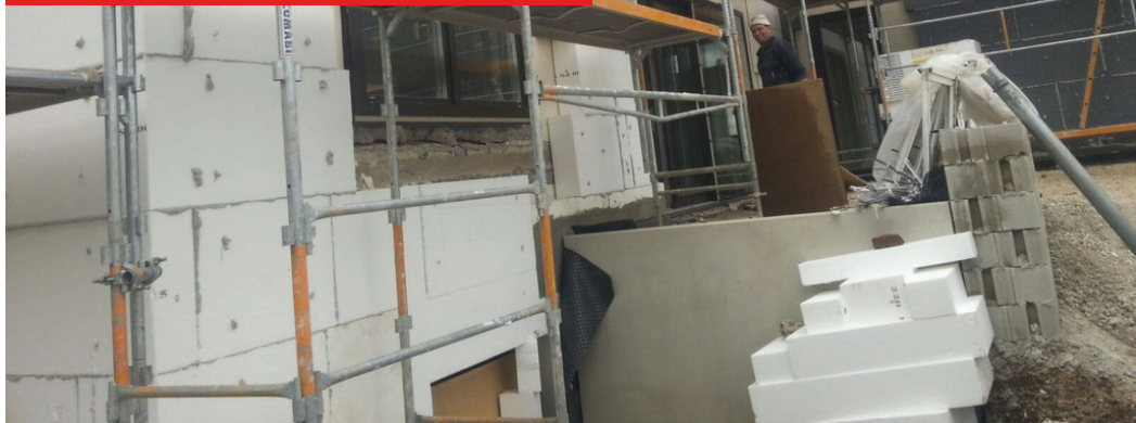
Rénovation avec isolation extérieure
